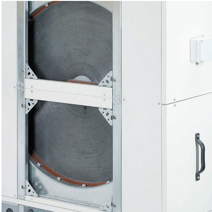
XPRR секція ротаційного рекуператора. ККД до 85%
